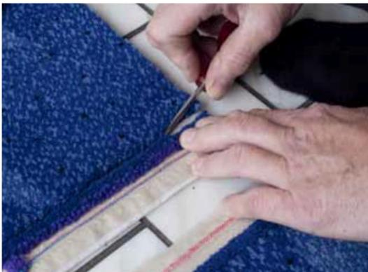
Der Teppichboden-Hersteller hat einen Faden eingearbeitet, damit das Schneiden der Ränder leichter fällt. Wie auf der Abbildung zu sehen, muss dies nah am Teppich geschehen.
