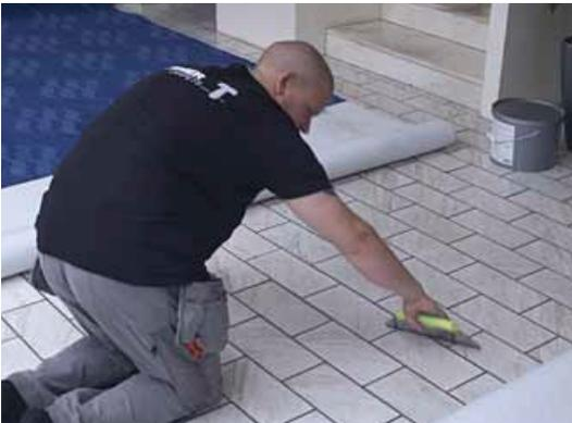
Die beiden Bahnen sind am Stoß zurückzubiegen, damit der Klebstoff auf den Boden aufgebracht werden kann.
