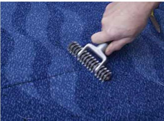
Die Stoßstelle ist mit einer Stachelwalze zu bearbeiten, damit sie nicht mehr sichtbar ist.
