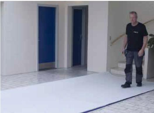
Die innere Hälfte der Rolle ist zurück zu schlagen, sodass der Untergrund darunter sichtbar wird.
