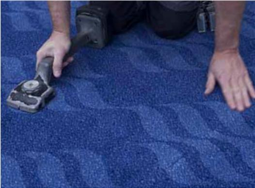
Zum Zusammenfügen der Muster kann ein sog. Power-Stretcher (mit entsprechender Vorsicht) verwendet werden.
